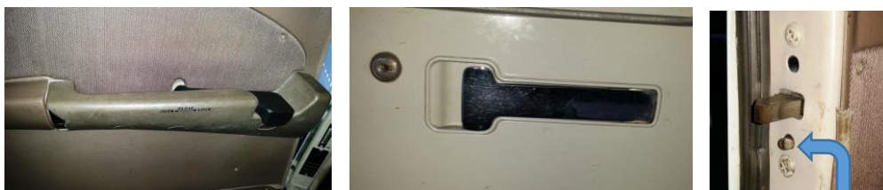
Handtag och låskolv i stängt läge - Styrtapp för utlösning av kolven
